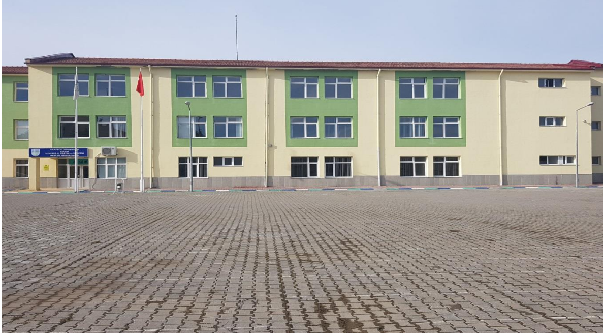
Resim 12. Eflani Meslek Yüksekokulu Binası
