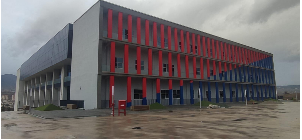
Resim 43. Mühendislik Fakültesi Laboratuvar İnşaatı
