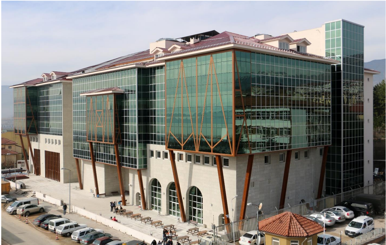
Resim 4. Safranbolu Fethi Toker Güzel Sanatlar ve Tasarım Fakültesi Binası
